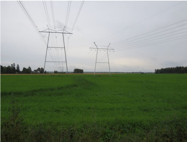
20. Johtoreitti SVE C Munakantieltä etelään.
