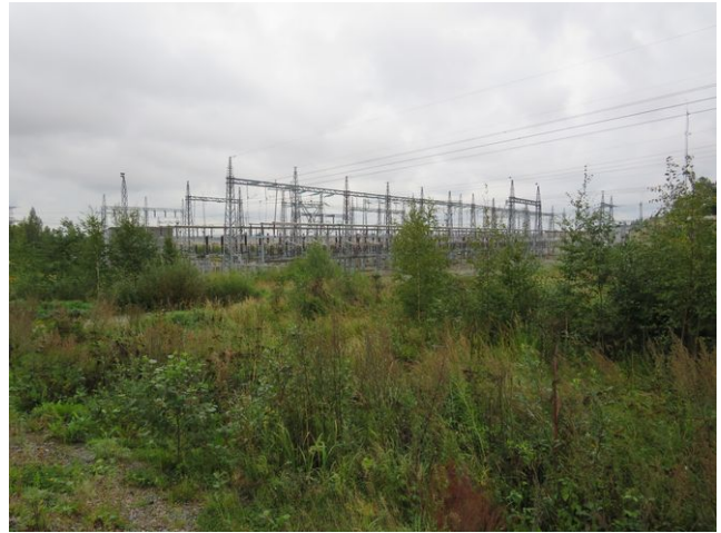
21. Ahonkylän muuntoasema, koilliseen.
