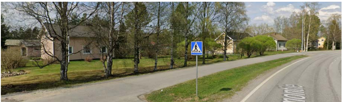
Kuva 5. Suunnittelalueen rakennukset tonteilla 3-5 ja 7. Kuva: Google Street View 2023.
