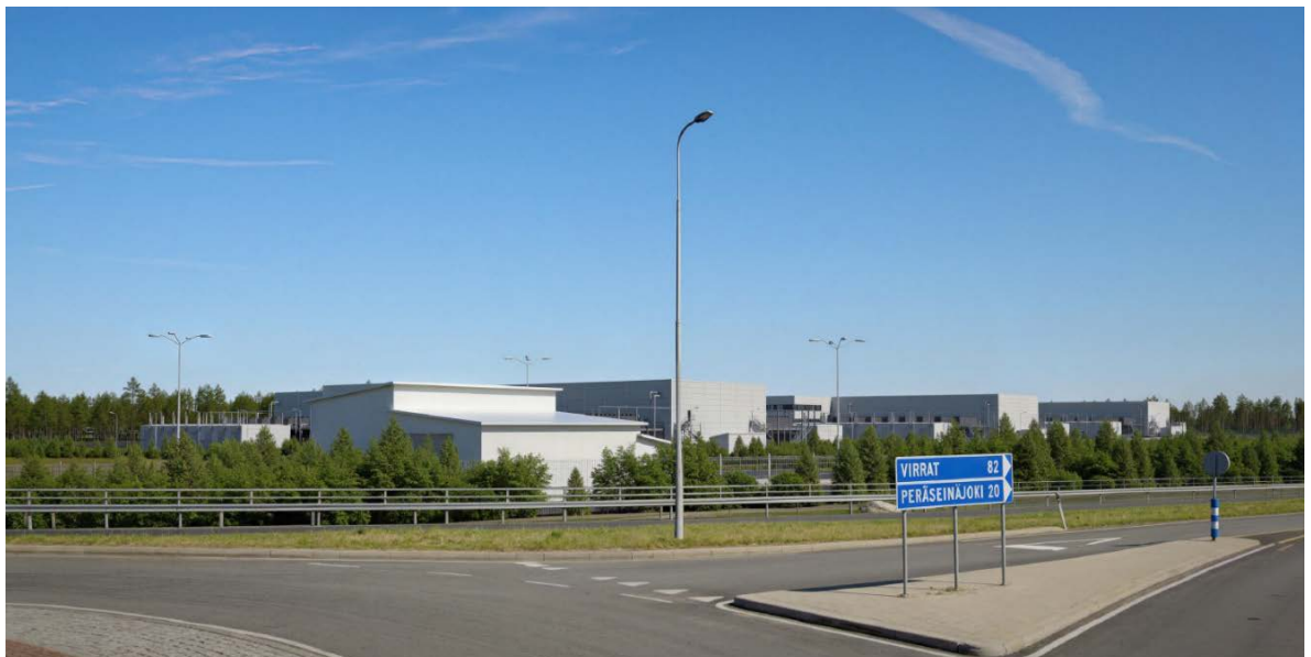
Kuva 14. Kuva Seinäjoentieeltä. Ensimmäinen rakennusvaihe. Kuva Pure DC.
