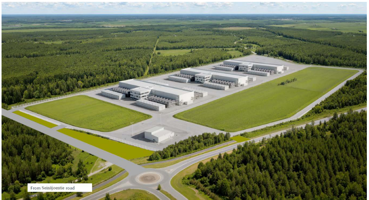
Kuva 15. Viistokuva Seinäjoentieltä alueelle. 1. rakennusvaihe. Kuva Pure DC.
