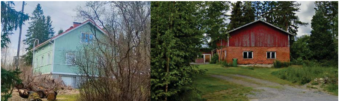
Kuva 6. Kitinojantie 48 asuinrakennus kuvattuna keväällä 2025 Kitinojantieltä ja ulkorakennus Google Maps 2019.
