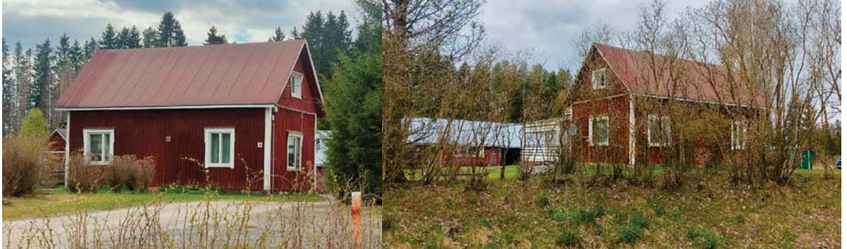
Kuva 5. Kitinojantie 14 pihapiiri kuvattuna keväällä 2025 Kitinojantieltä.
