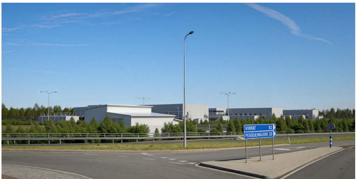
Kuva 13. Kuva Seinäjoentieeltä. Ensimmäinen rakennusvaihe. Kuva Pure DC.
