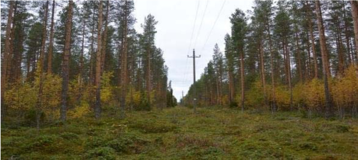
Kuva A. Sähkölinja
