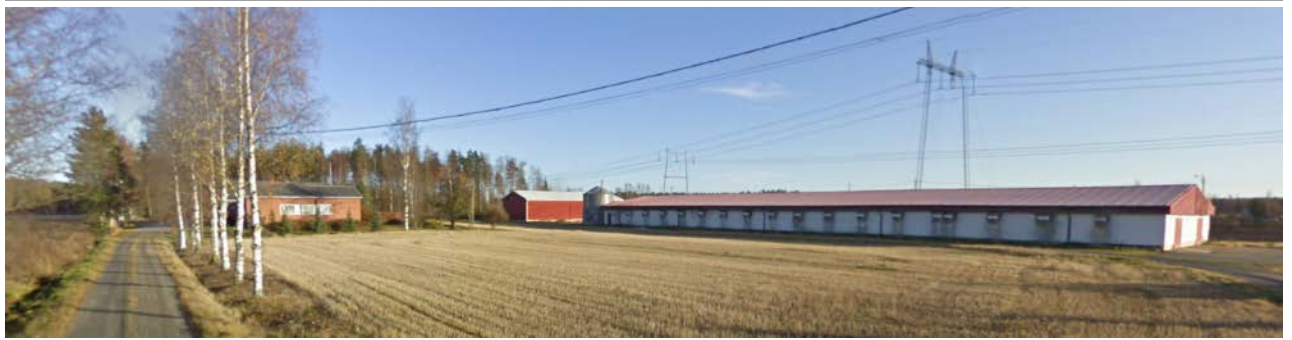
Kuva. Palosaarenkuja 4, varasto ja kanalarakennus. Google Maps 2009.
