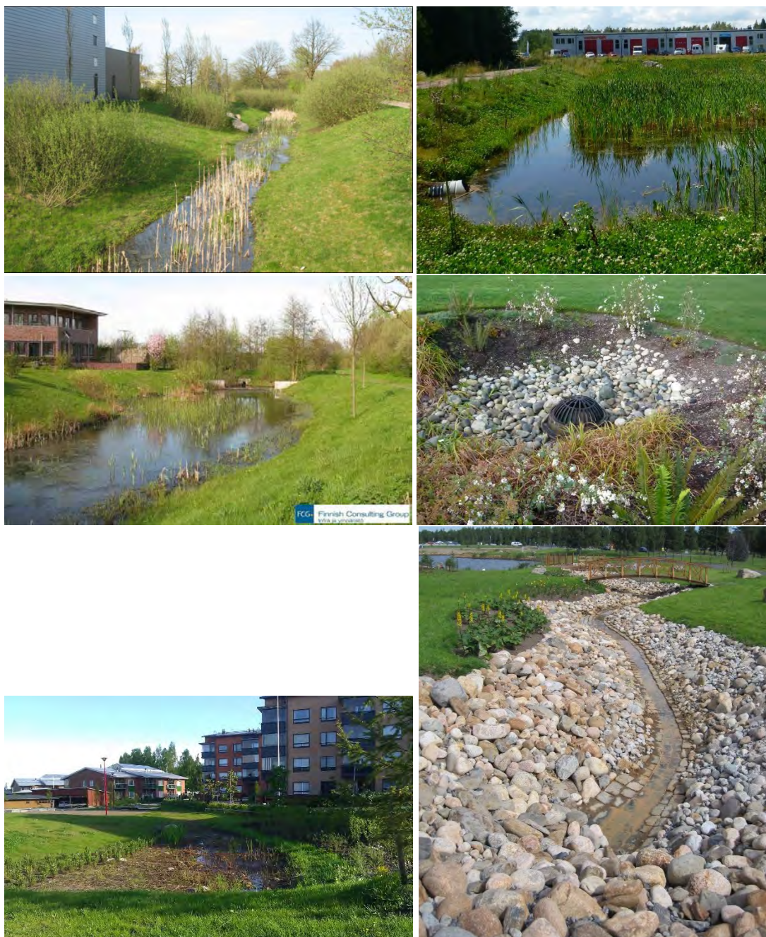
Esimerkkikuvia hulevesiratkaisuista. (kuvat:FCG)
