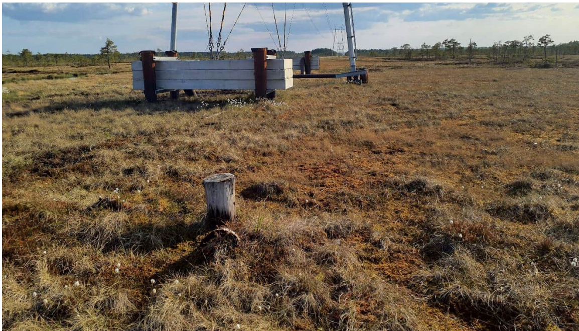
Kuva 16. Olemassa oleva 110 kV voimajohdon pylväspaikka Paukanevan Natura-alueella.
