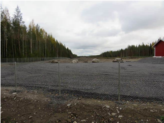
4. Rakenteilla oleva Lapuan ampuarata, itään.
