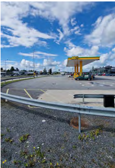
Kuva 1. Alueen itäreunalla sijaitsee polttoaineenjakuasema.
