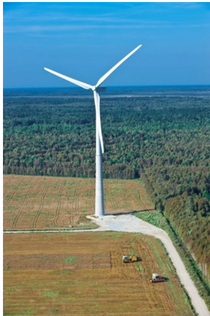
Kuva 4. Kuva teräsbetonirakenteisesta tuulivoimalasta ja periaatekuva tuulivoimalasta (Lähde: WinWind Oy).
