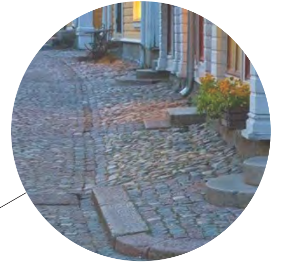
Kivettyä ajoväylä sekä korotettu reunakivi ja luonnokiveys rakennuksen sivustalla, lähde: Pinterest
