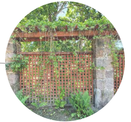
Pergolamainen aita luo suojaisan oleskelupihan ja pihapiirin rakennuksen ympärille
