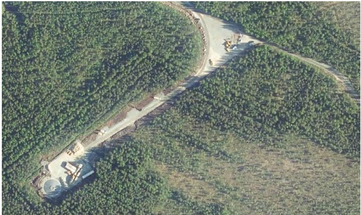
Kuva 8. Esimerkki tuulivoimalan rakennustyömaasta. Ilmakuvan lähde: Maanmittauslaitos, avoimet aineistot 2022
