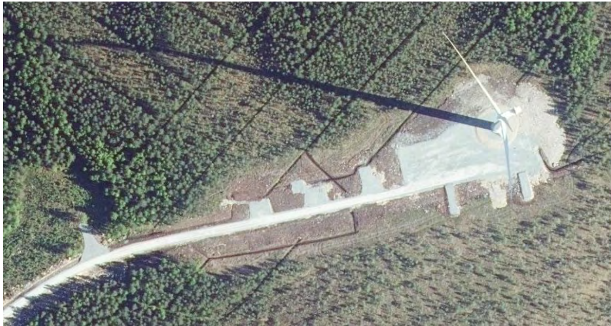
Kuva 9. Esimerkki juuri valmistuneen tuulivoimalan asennusalueesta. Ilmakuvan lähde: Maanmittauslaitos, avoimet aineistot 2022.
