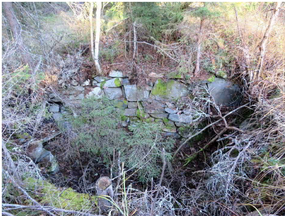
Kellari, joka on mahdollisesti ollut aiemmin tervavarasto ja rakennettu halssin kohdalle, kuva itään.
