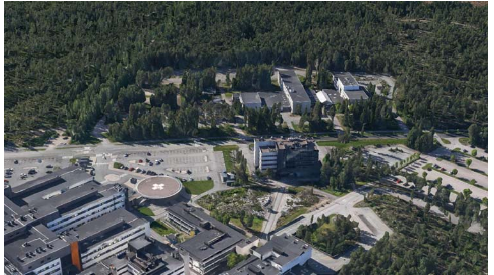
Kuva. Viistoilmakuva idästä suunnittelualueelle. Etulalla sairaalan alue ja helikopterin laskeutumistaso noin 4,5 metrin korkeudella maasta, mikä vaikuttaa suunnittelualueen rakennusten korkeustasoihin.
