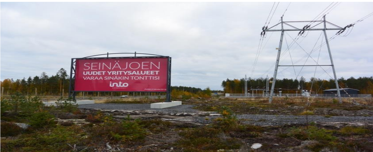
Kuva E. Seinäjoen itäinen ohikulkutie, voimalinja ja sähköasema
