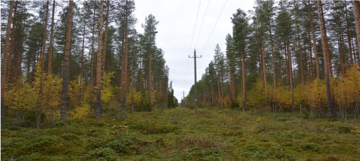
Kuva A. Sähkölinja
