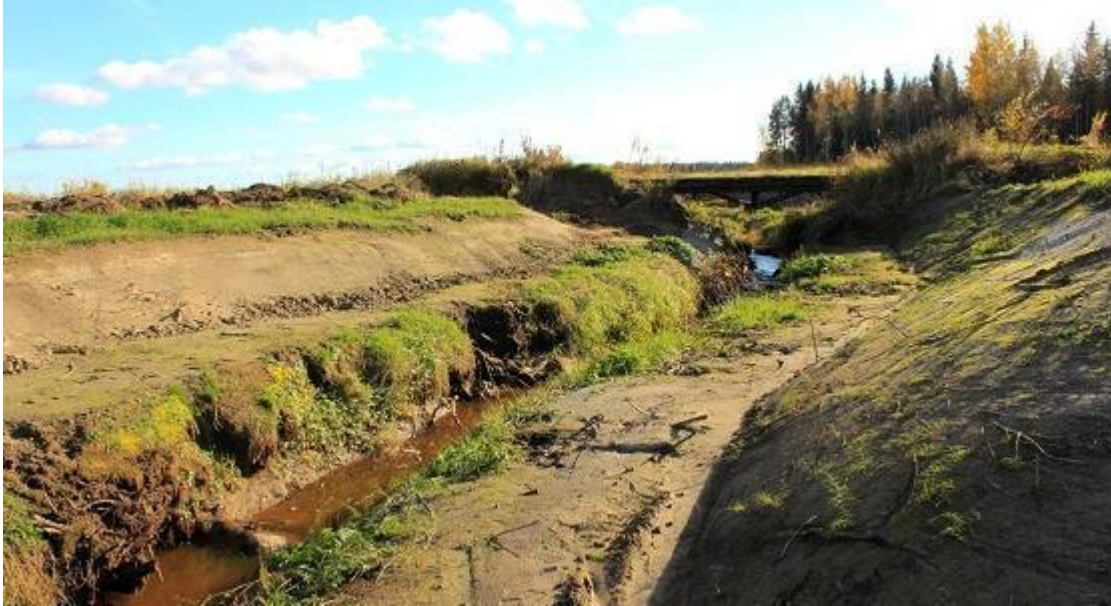
Kuva 2 Kaksipuoleinen tulvatasanne Tyrvän Leppiojalla. © Pinja Kasvio ( https://www.ymparisto.fi/fi-FI/Vesi/Vesien_kaytto/Maankuivatus_ ja_ojitus/Luonnonmukainen_peruskuivatus )
