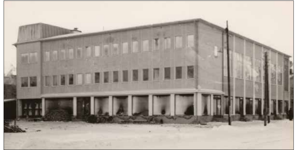
Rakenteilla oleva maakuntatalo kuvattuna vielä keskeneräisenä vuosina 1957-58. (Porstua-verkkopalvelu)
