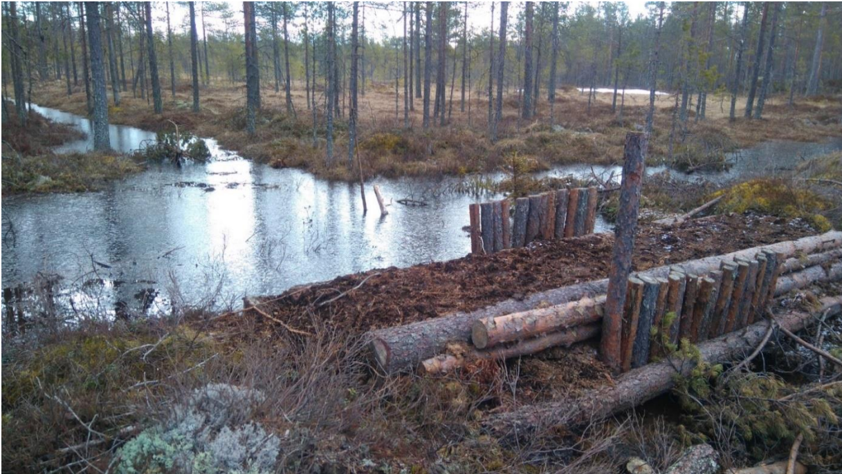
Kuvat 9 ja 10. Käsityönä tehtävän padon malli, kuvattuna rakennettaessa ja seuraavana keväänä.
