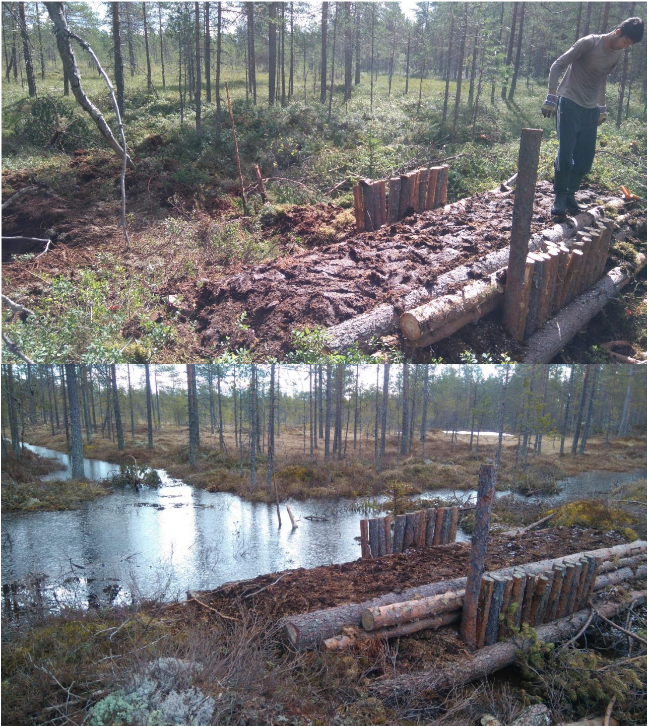
Kuvat 6 ja 7. Käsityönä tehtävän padon malli, kuvattuna rakennettaessa ja seuraavana keväänä.
