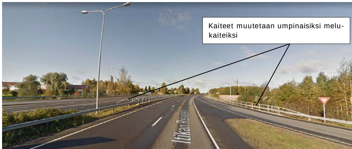
Kuva 5.1.1.2. Kyrönjoen nykyiset sillankaiteet Pohjan valtatiellä. Ajoratojen pohjoisen puoleiset kaiteet esitetään muutettavan / korvattavan umpimelukaiteella. Kaava-alue jää kuvassa oikealle. Kuva Google maps.
