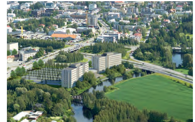
Arto Sipisen toimiston suunnittelemat toimistotalot Itkanmäellä. Kuvan ensimmäinen rakennus on valmistunut keväällä 2010. Korkeat rakennukset työntyvät valitettavan lähelle jokea ja Vaasantie rajautuu tympeään pysäköintialueeseen.
