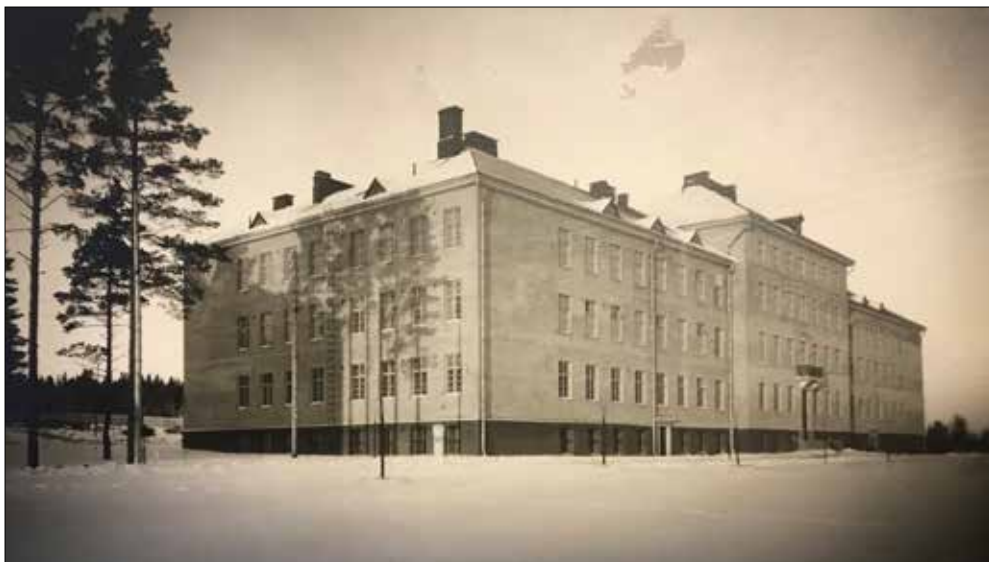
Sairaalarakennus kuvattuna mitä ilmeisimmin 1950-luvulla ja vesikatteen on vaihtunut tiilikate. Näkyvimmit eroavaisuudet nykyasuun ovat katonlapeessa olevat kolmikulmaiset kattolyhdyt sekä selkeästi erottuvat sisäpuoliset turvaikkunat. (Valokuva Etelä-Pohjanmaan sairaanhoitopiirin kokoelmat.).
