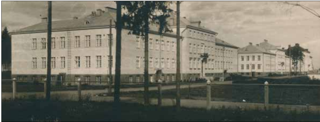
Nykyiset TC- ja TB-rakennukset kuvattuna mahdollisesti 1950-luvulla. Taustalla erottuu heikosti myös TA-rakennus. Etualalla kaatumatautisten hoitolaitoksen ja mielisairaalarakennukset erottava verkkoaita sekä nykyinen Seuralantie. (Valokuva Etelä-Pohjanmaan sairaanhoitopiirin kokoelmat.)
