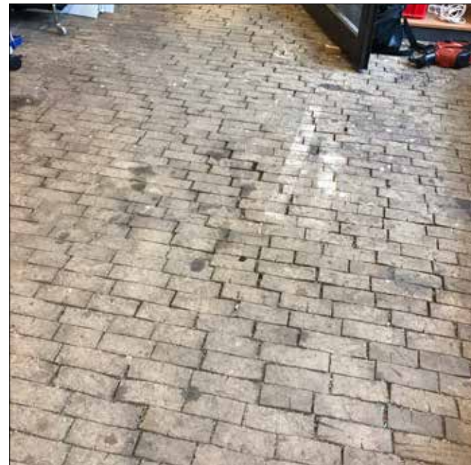
Verstaan tiloissa on tallella alkuperäinen puupölkkylatattia pehmentämässä koneiden aiheuttamaa tärinää.
