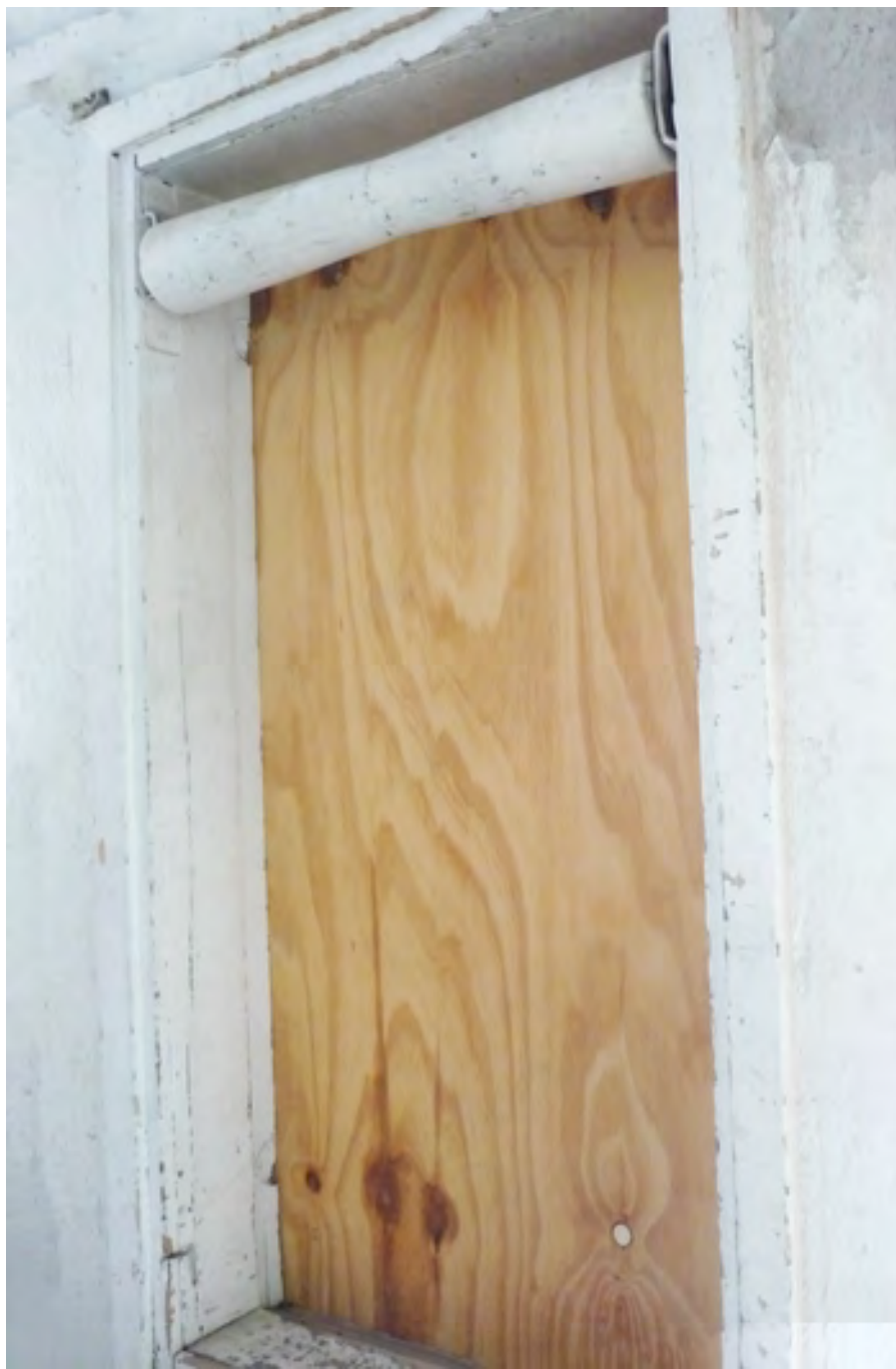
Paloasema, sisäkuva, letkujen kuivausaukko ja -tela, sisäkuva väestösuoja.
