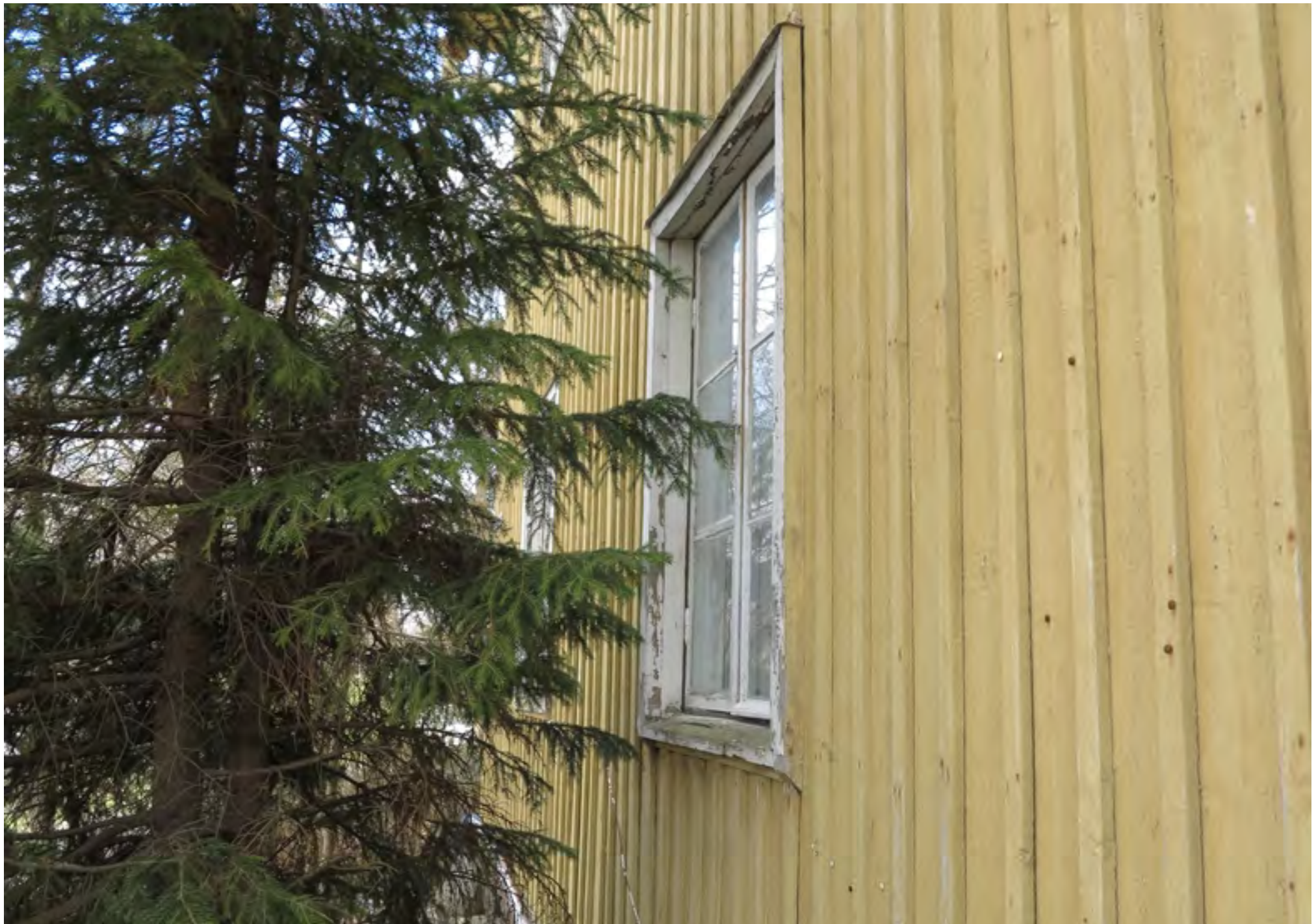
Larvala itäpäädyn seinää, ikkuna ja vuorausta
