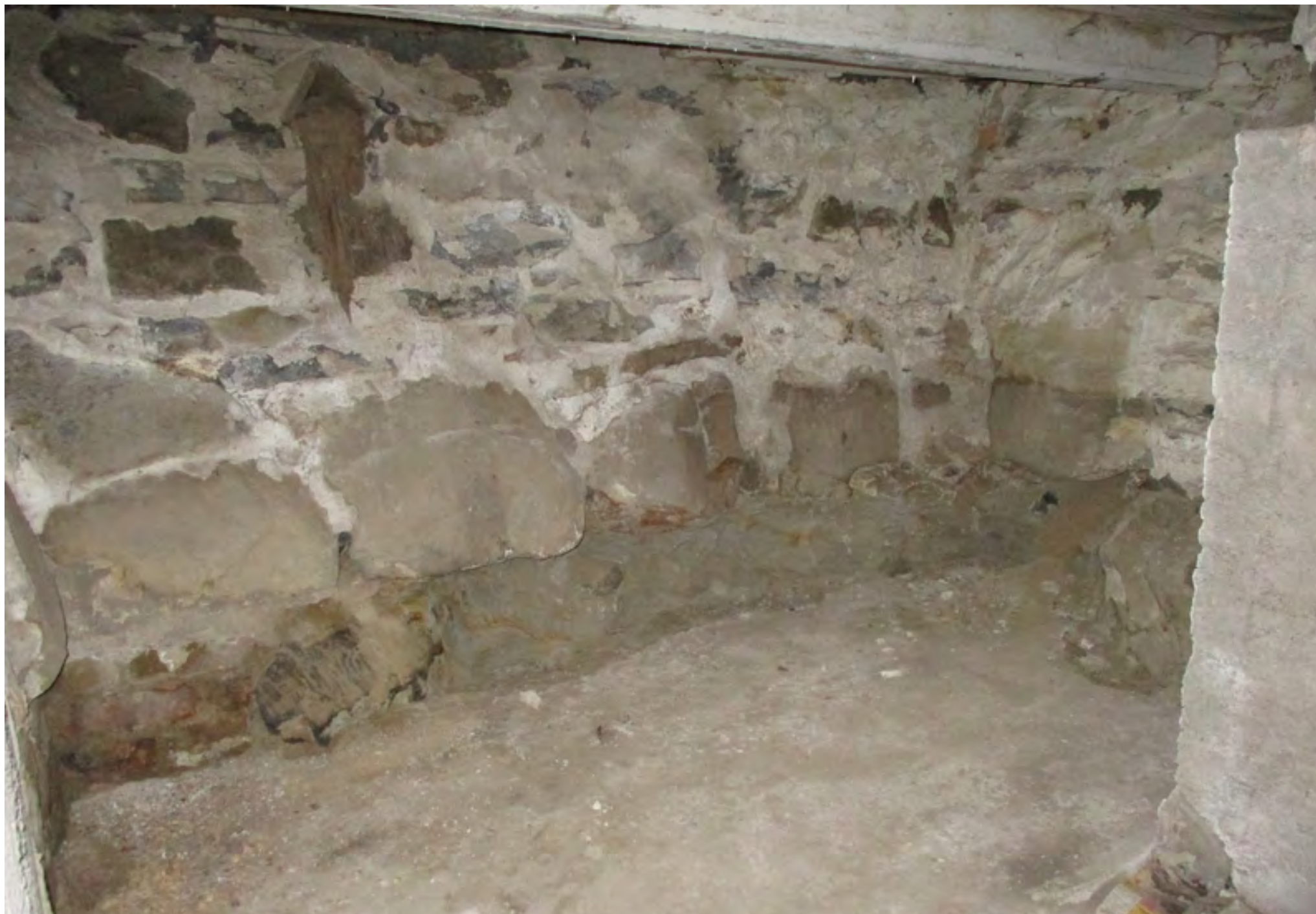
Larvala itäpäädyn seinää, ikkuna ja vuorausta
