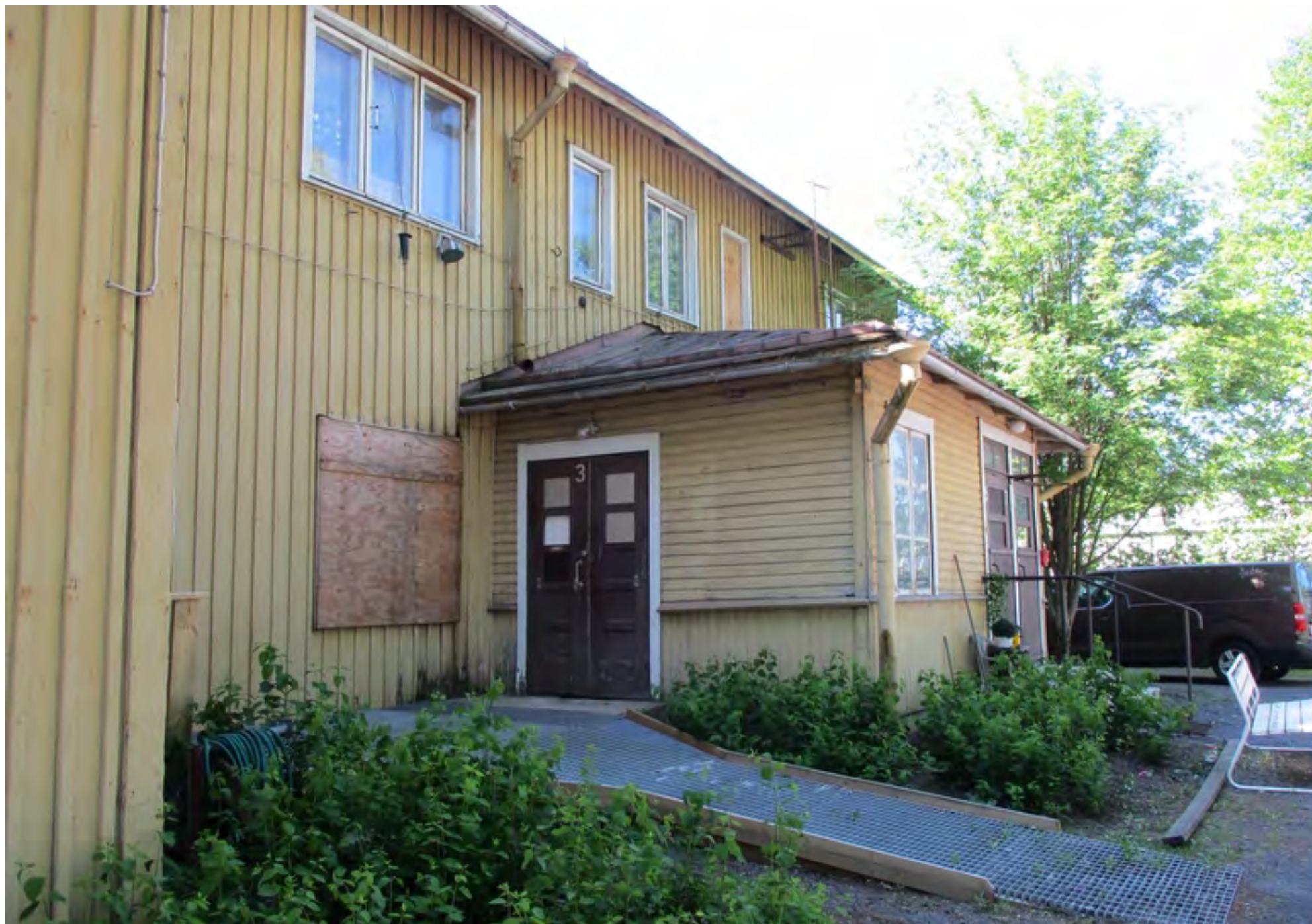
Larvala pohjoissivun kuistirakennelmat ja ajoluiska, kuvattu koillisesta
