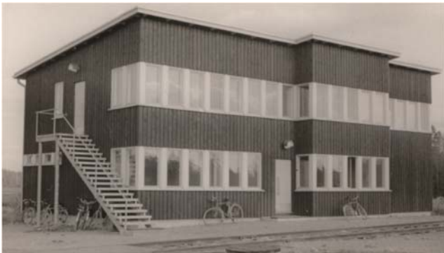
Pienehkö, kaksikerroksinen rakennus, jossa on junansuorittajien työtila. Seinäjoen maakuntakokoelma. Kuvanunero: 859.
