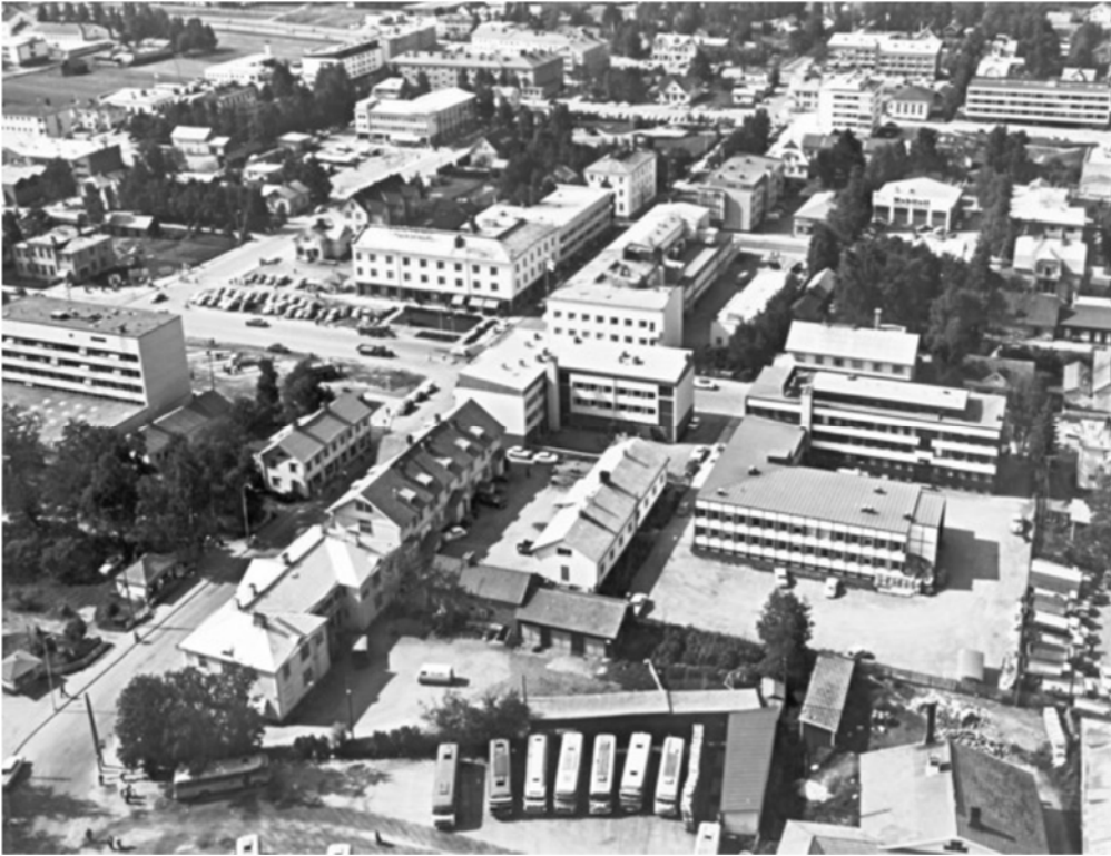
Ilmakuva Seinäjoen keskustasta asemalta päin kuvattuna vuonna 1960. Alalaidassa on linja-autoja pysäköitynä linja-autoasemalle. Keskellä on keskustori eli Jaakontori. Autoja seisoo siellä pysäköitynä. Paljon kerrostaloja, mutta vielä jäljellä vanhaa rakennuskantaa. Ylälaidassa keskellä on pieniä taloja paikalla, johon myöhemmin rakennettiin Kelan talo. Seinäjoen maakuntakokoelma. Kuvanumero: 4256.
