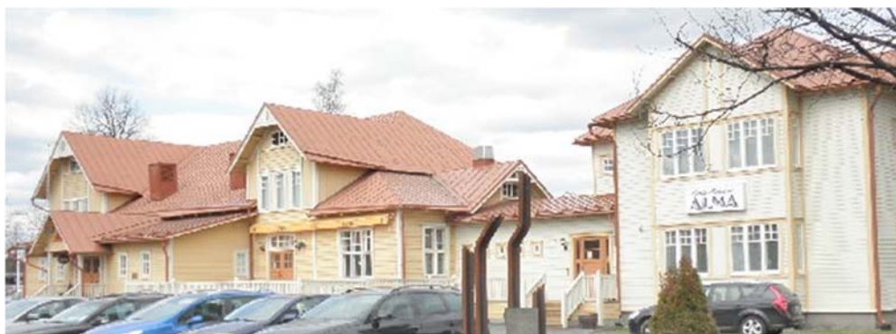
Entinen rautatieläisten talo, josta on kunnostettu Hotelli-Ravintola Alma ja Hotelli-Ravintola Alman laajennus. Kuvaaja Jenni Rauhala 5.5.2011. Kioski: Inventointihanke: Seinäjoen keskusta 2011.
