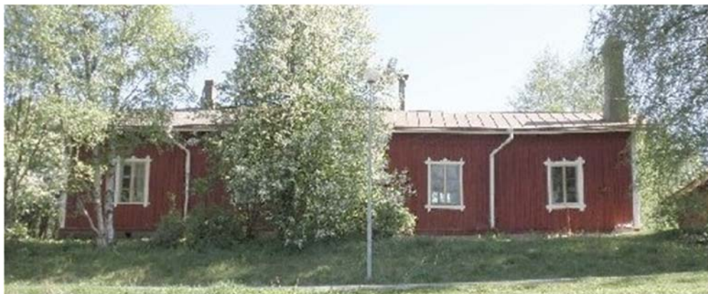
Pumppuasema. Kuvaaja Jenni Rauhala 20.5.2010. Kioski: Inventointihanke: Seinäjoen keskusta 2011.
