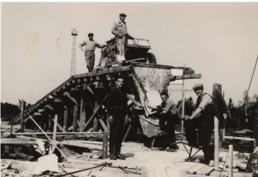
Kuortaneentien tunnelien työmaalla on suuri rakennelma. Kaksi työmiestä seisoo sen päällä laitteineen. Kolme miestä on maan pinnalla. Tunnelit rakennettiin 1950-luvulla. Seinäjoen maakuntakokoelma. Kuvannumero: 988
