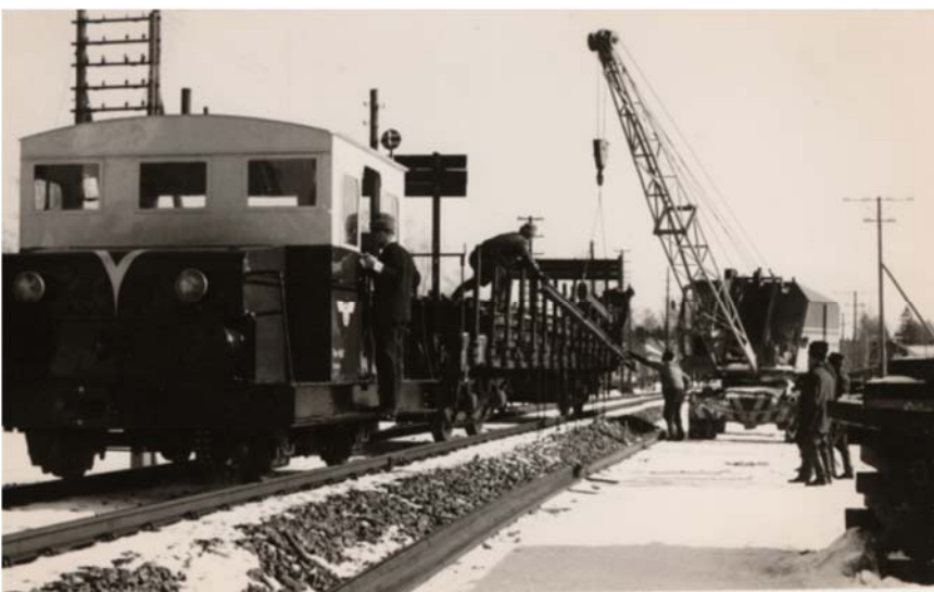
Seinäjoen-Parkanon radan rakentaminen alkanut talvella 1965. Junan avovaunusta nostetaan nosturin avulla ratakiskoja maahan. Seinäjoen maakuntakokoelma. Kuvannumero: 895.
