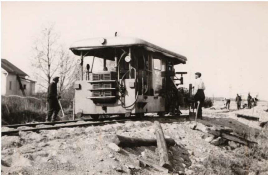
Radankorjausporukka seisoo radan varressa sveitsiläisen koneen ja insinöörin kanssa tutkimassa kiskojen kuntoa. Kone seisoo kiskoilla ja miehet ovat sivussa lapioineen ja muine työkaluineen. Tarkastus tehdään vuonna 1965. Seinäjoen maakuntakokoelma. Kuvannumero: 867.
