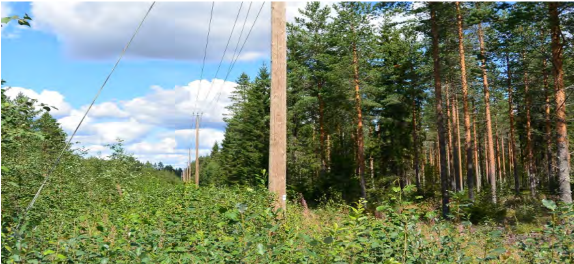
KUVA T Sähkölinja Routakalliontieltä pohjoiseen
