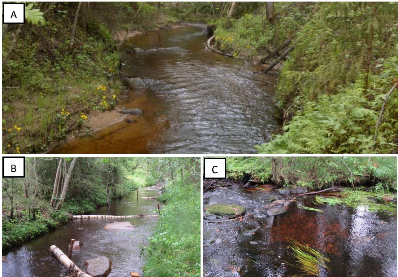
Kuva 25. Kunnostettu purouoma (A), jonka mutkittelua pyritään lisäämään mm. puusuisten avulla (B). Uoma on myös kivetty ja sinne on toteutettu kutusoraikkoja (C).
