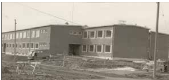
Kivistön yksityinen vanhainkoti rakenteilla vuonna 1965. (Valokuva Portua-verkkopalvelu.)
