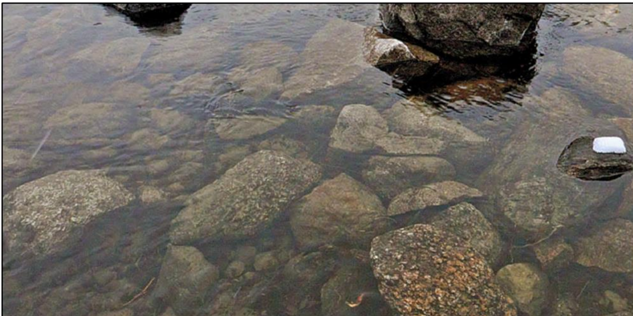
Kuva 7. Kerroksellista poikaskivikkoa ja suurempia yksittäisiä kiviä sitomassa rakennetta.
