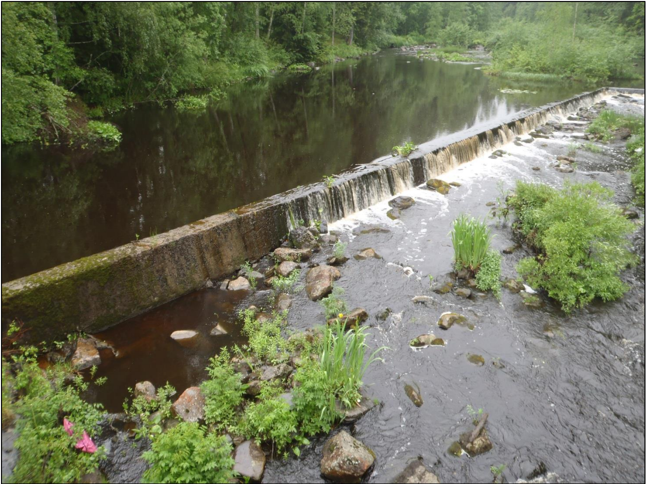
Kuva 11. Björkenheimin sillan betonipatoa. (kuva Tommi Seppälä)
