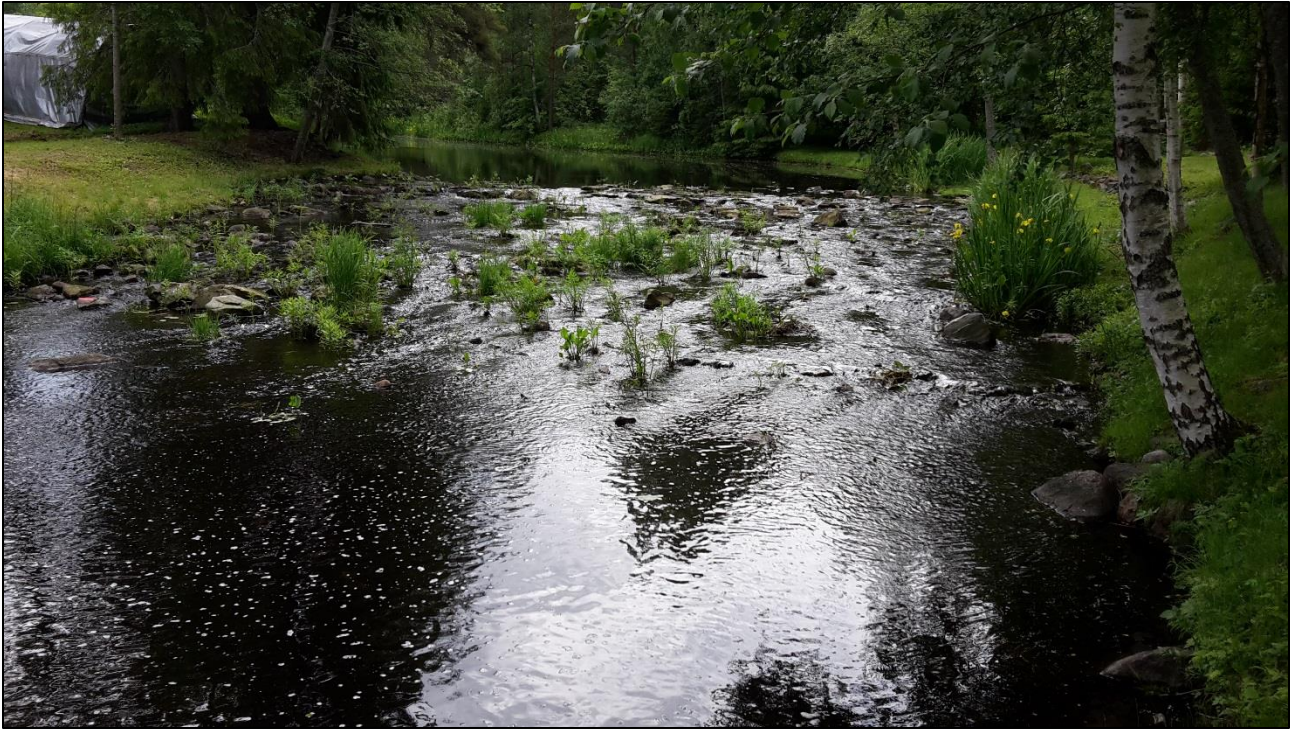
Kuva 14. Vuorikosken yläpuolen pohjapatoa
