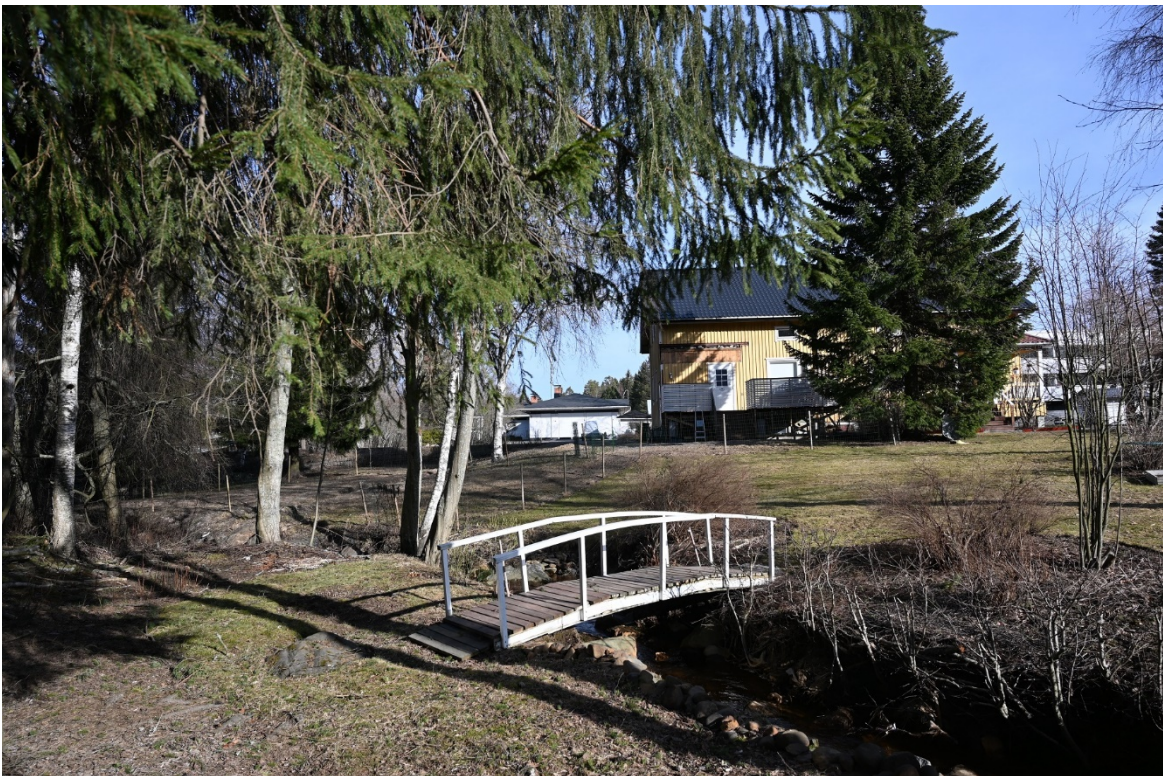
Kevytrakenteinen silta Tuomikatu 4:n pihassa.
