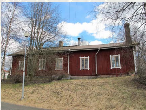
Kuva 6. VR:n pumppaamorakennus Marttilassa.
