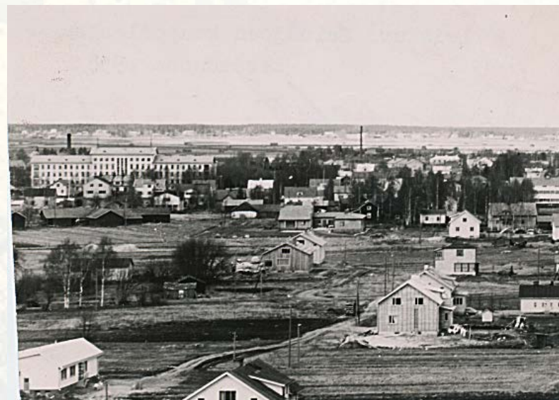
Kuva 14. Entinen lääninsairaala kohoaa massiivisena rakennuksena harvaan rakennetun Marttilan pientaloalueella. 1950-luvun loppu. Etelä-Pohjanmaan maakuntakokoelma.
