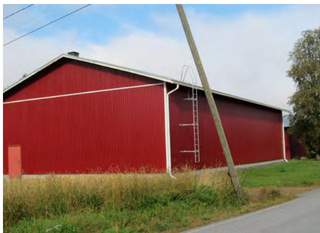
Kuva 37. Uusi tilarakennus. Rakennuksen suuri koko, materiaali ja ikkunattomuus eroaa perinteisestä.
