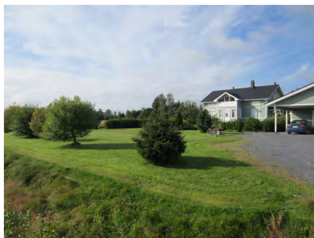
Kuva 30. Uudisrakennuksen pihapiiri on avoin, jolloin rakennus korostuu liikaa.
