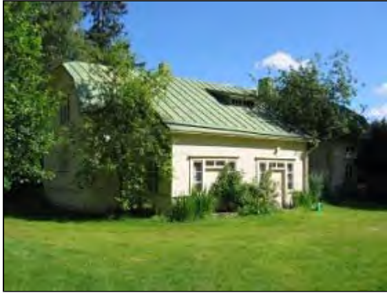
Hietämäen päärakennuksen pihasivu. Kuvaaja: Merja Suomela Kuvausaika: kesä 2004
