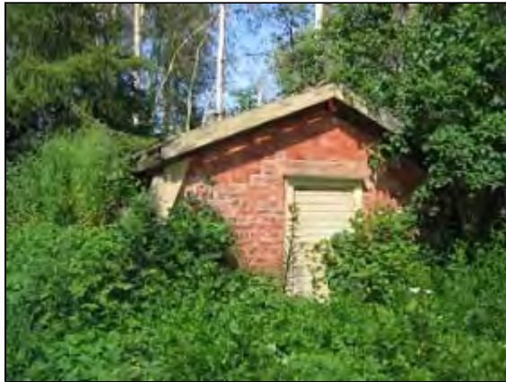
Kuoppa, päärakennuksen puoleinen pääty. Kuvaaja: Merja Suomela Kuvausaika: kesä 2004
