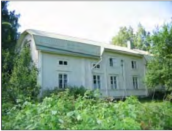
Hietämäki päärakennus, tienpuolen julkisivu. Kuvaaja: Merja Suomela Kuvausaika: Kesä 2004
