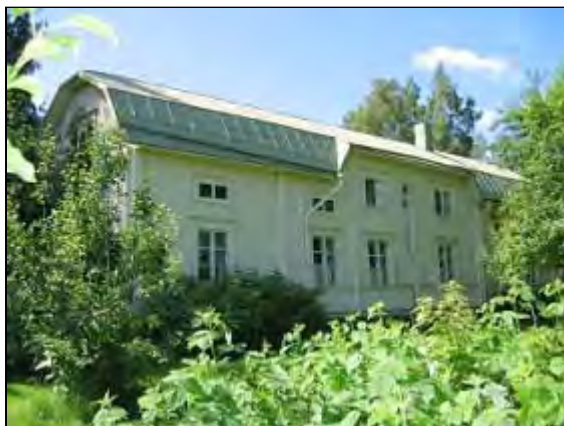
Hietämäen päärakennus, tienpuolen julkisivu. Kuvaaja: Merja Suomela Kuvausaika: Kesä 2004
