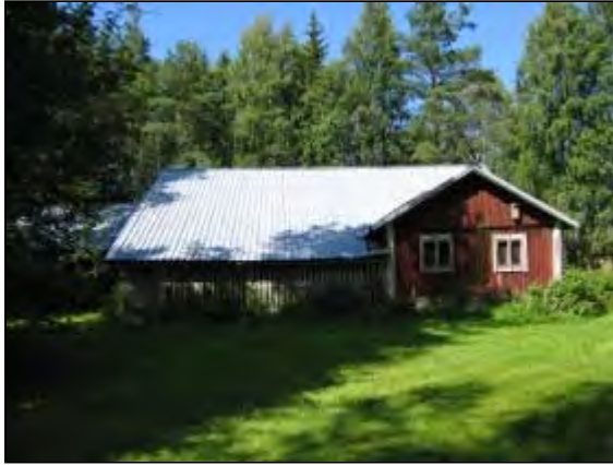
Hirsirunkoisessa osassa on tallin pääty. Kuvaaja: Merja Suomela Kuvausaika: Kesä 2004
