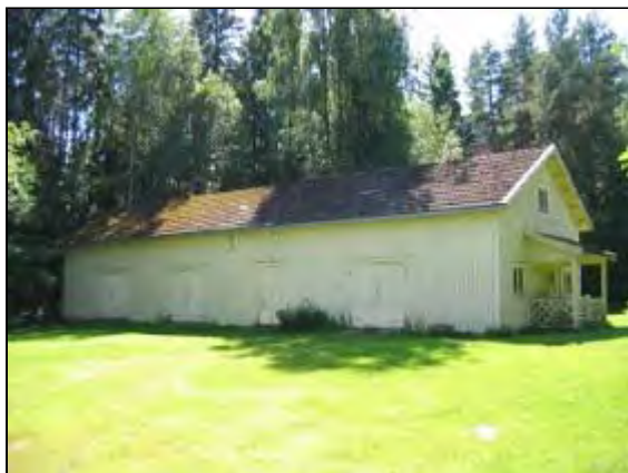
Päärakennuksen puoleinen julkisivu. Kuvaaja: Merja Suomela Kuvausaika: Kesä 2004
