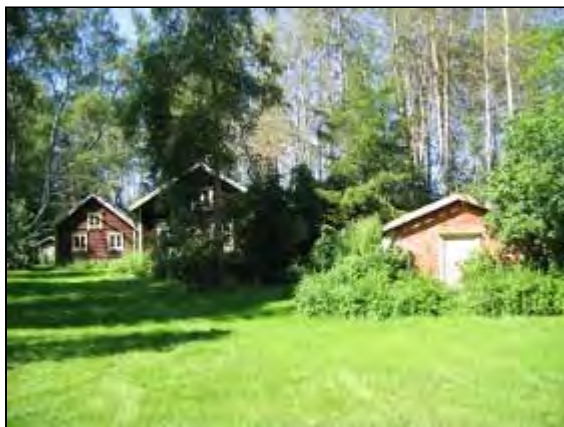
Rakennukset oikealta vasemmalle: kuoppa, paapantupa, pienasumus ja kaivohuone. Kuvaaja: Merja Suomela Kuvausaika: Kesä 2004
