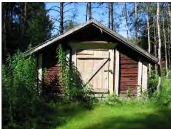
Pihan reunalla sijaitseva kaivohuone. Kuvaaja: Merja Suomela Kuvausaika: Kesä 2004
