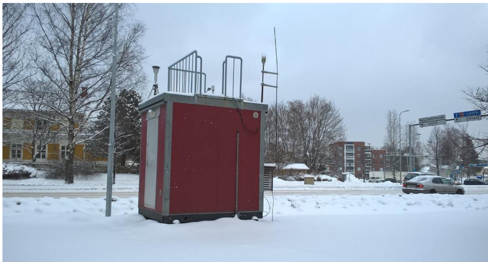
Kuva 7. Seinäjoen mittausasema, Vapaudentie 6a.
