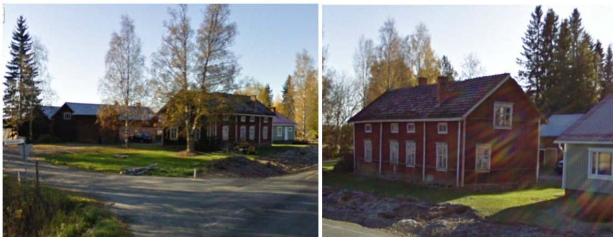
Lehtimäen eli Tassin rakennuksia. Vanha tupa on purettu vuonna 2010. Kuva Google Maps.
