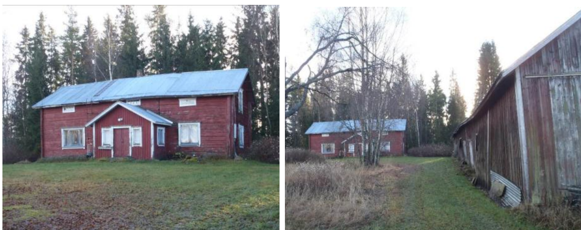
Mäntylän vanha tupa ja ulkorakennus pienen metsäsaarekkeen laidalla Pitkärannanmäellä.
