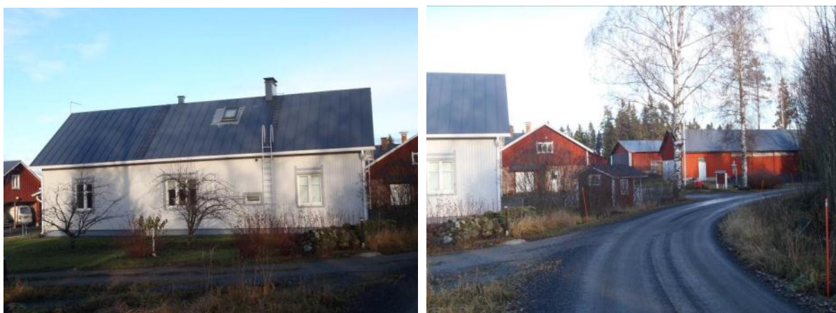
Pitkärantan taloa on jatkettu ja väritystä on muutettu punaisesta vaaleanharmaaksi.
