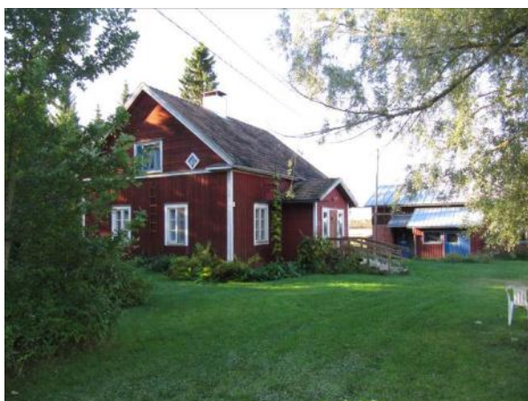
Rajalan päärakennus (v. 1939).
