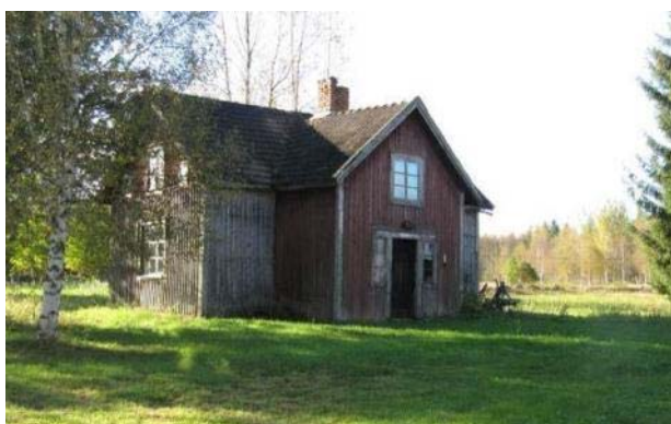
Kujanpään huonokuntoinen päärakennus.
