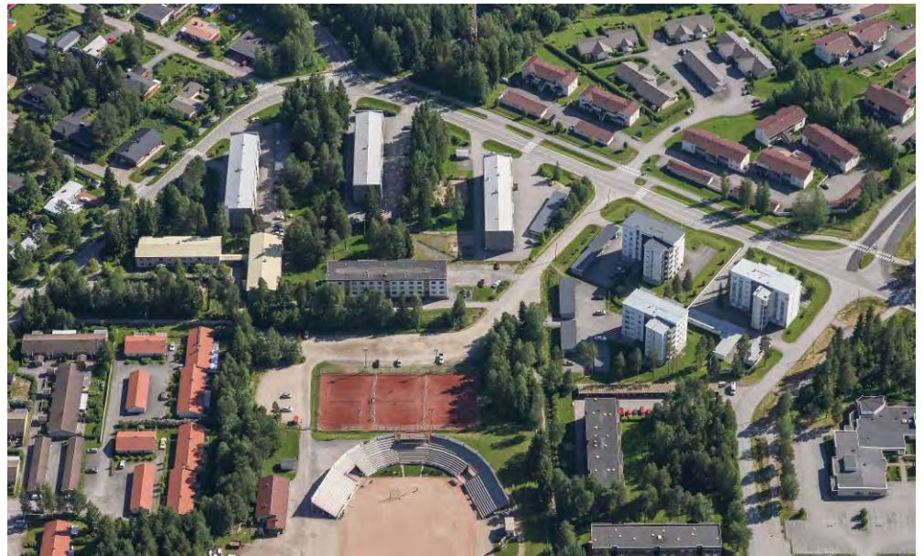
Suunnittelualue viistoilmakuva pohjoisesta. Kuvassa näkyy vielä tontilta purettu kolmikerroksinen kerrostalo.
