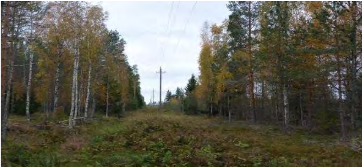
Kuva D. Sähkölinja
