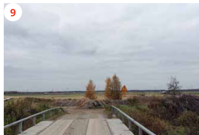
oikaisu-uoman silta upeilla näkymillä (muokattavissa jalankulkijoille helpommin käytettäväksi)
