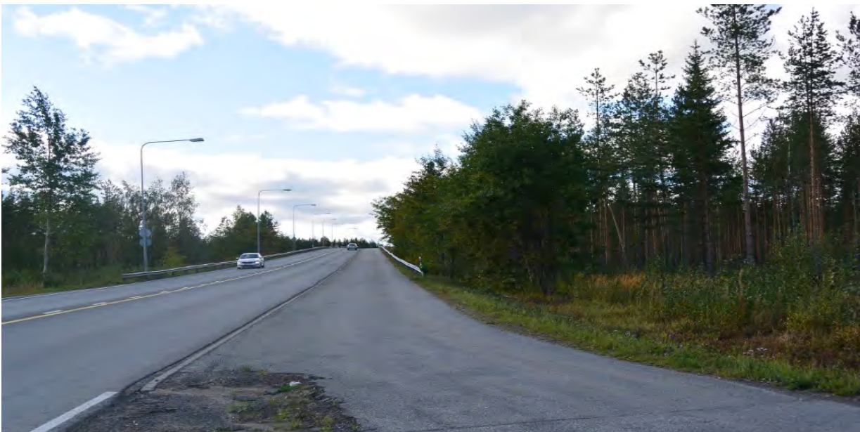
Kivistöntie Tuottajanpuiston itäpuolella. Kuvaussuunta lounaaseen.
