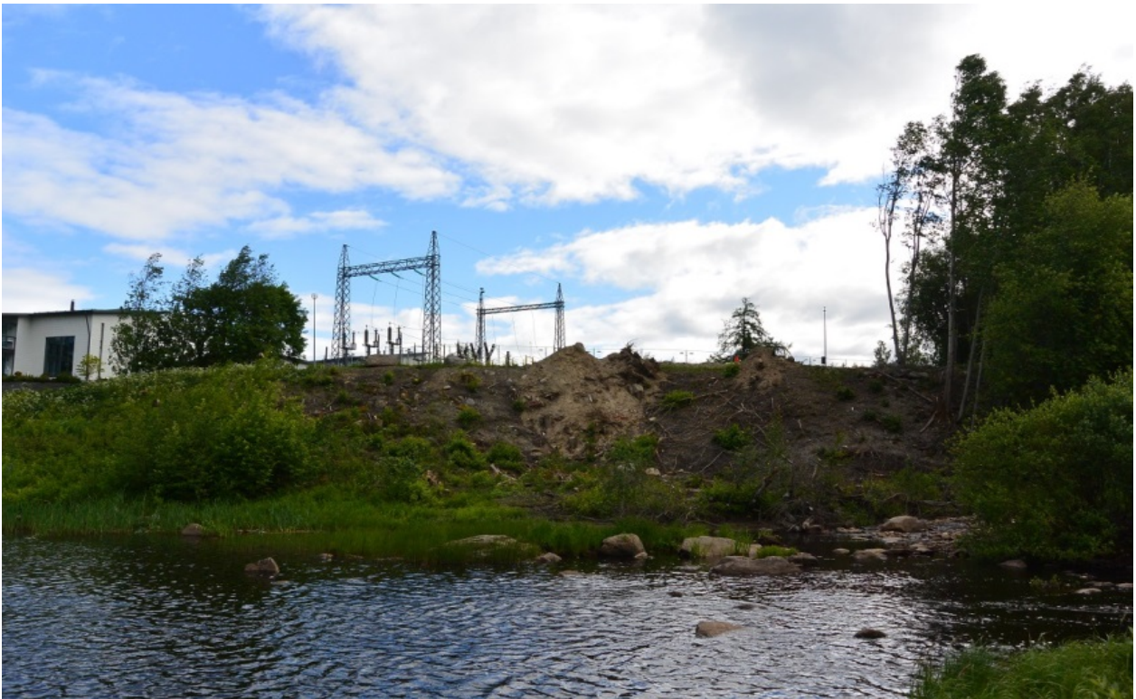
Kaavaillun uuden sähkölinjan uralla tehtyjä jokitörmän raivauksia.
