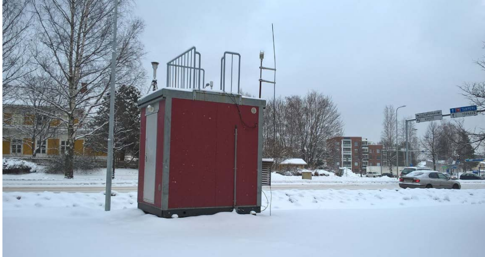
Kuva 7. Seinäjoen mittausasema, Vapaudentie 6a.
